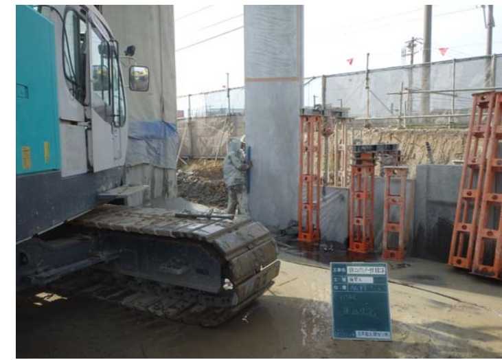
コンクリート矢板建込状況
