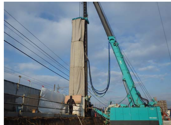
施工全景 軌道近接施工
