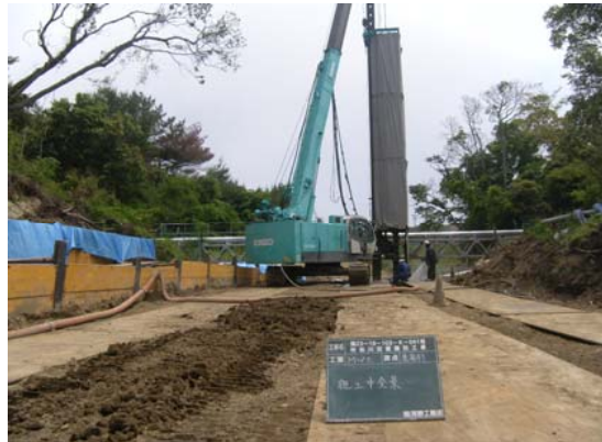
施工状況全景
