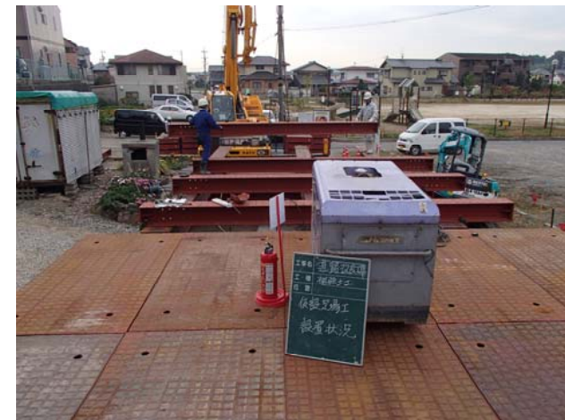
施工仮設足場架台
