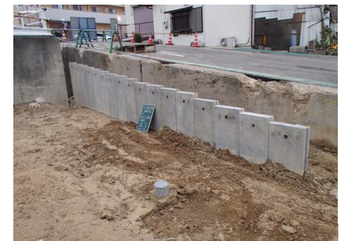
コンクリート矢板建込完了
