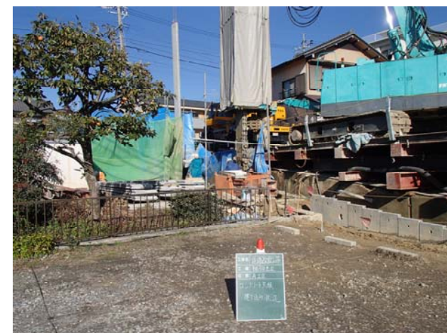
足場架台より施工状況
