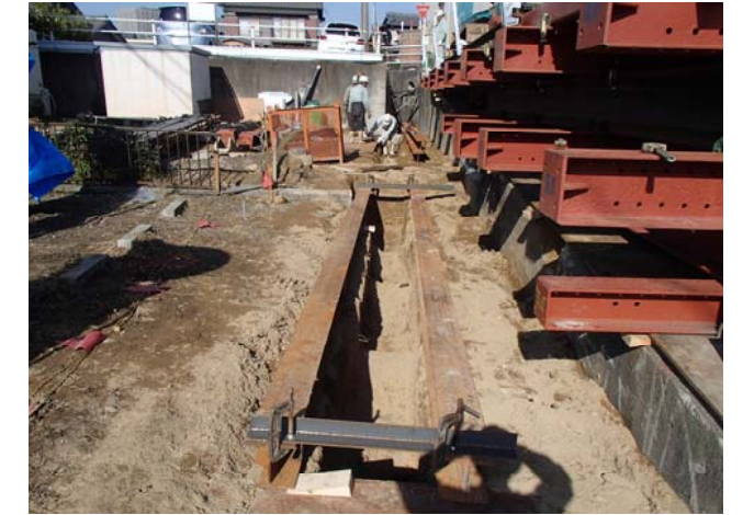
ガイド溝掘削固定規設置
