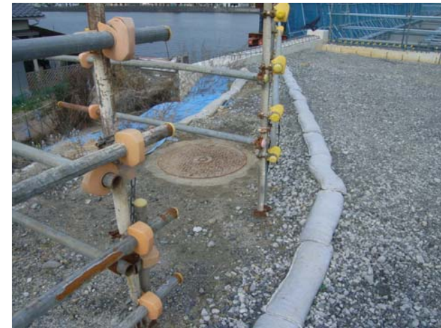
既設マンホール
