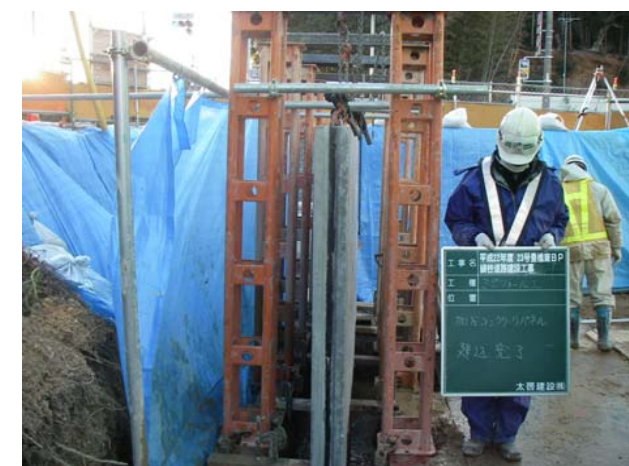
コンクリート矢板の固定
