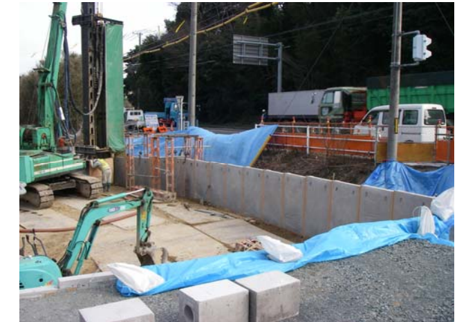
コンクリート矢板建込完了
