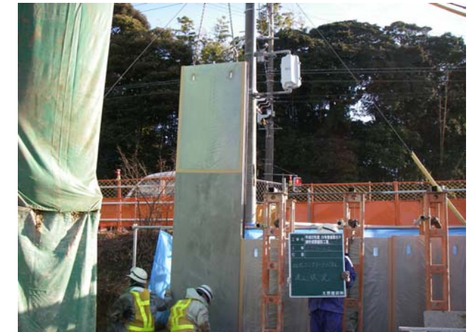
コンクリート矢板建込
