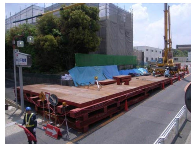
仮設足場設置状況
