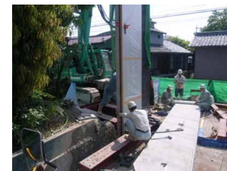
コンクリート矢板建込状況
