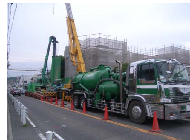
施工状況全景
