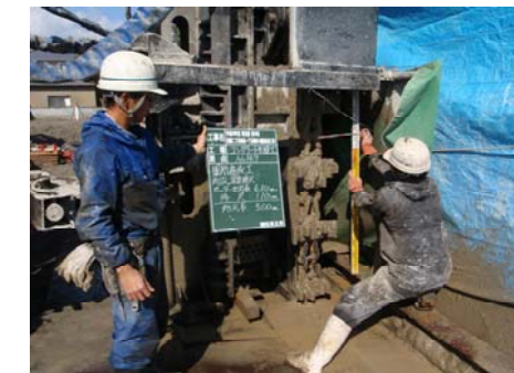
掘削全長確認
