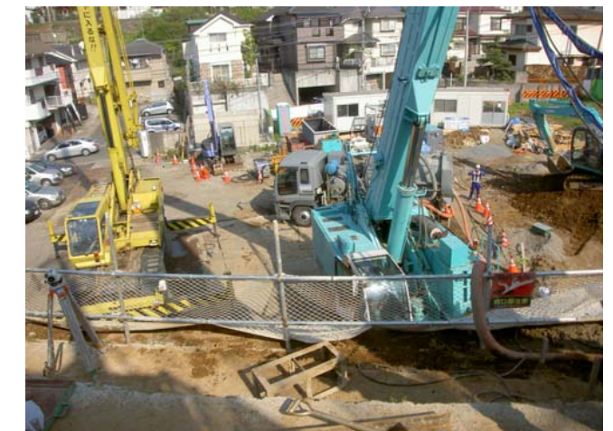
作業状況施工位置より機械を確認
