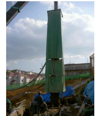
掘削造成状況
