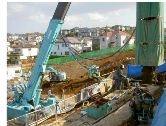
掘削造成状況
